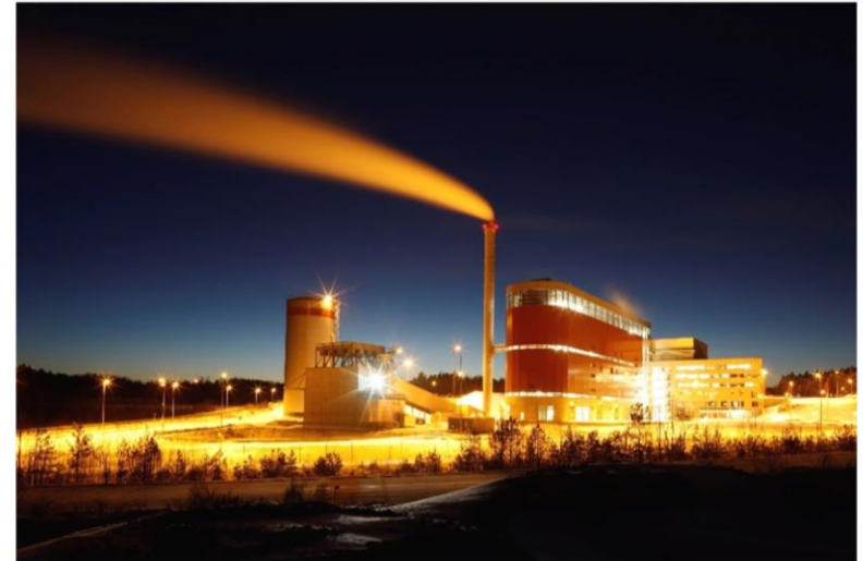
Uddevalla WtE plant, Sweden
